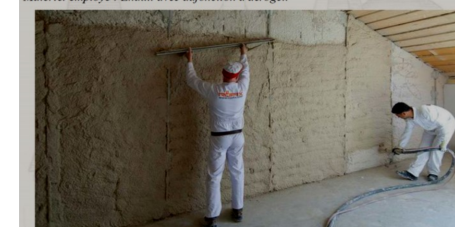
Matériau employé : Enduit avec adjonction d'aérogel.
